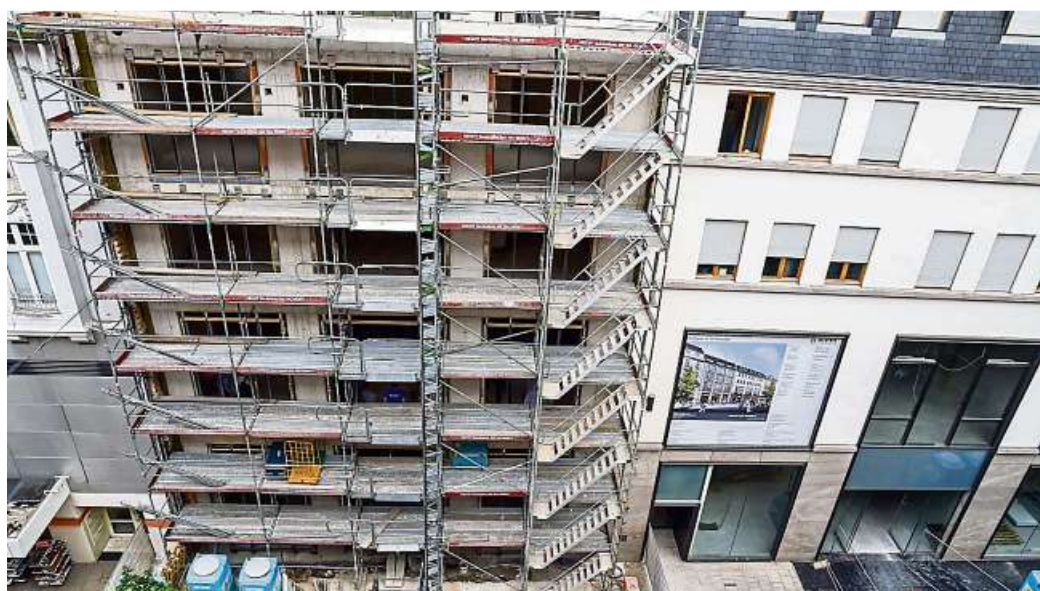
Bald soll im Gebäude Kirchgasse 13 der Innenausbau beginnen. Fertigstellung soll dieses Jahr sein. Zusammen mit dem Nachbargebäude (rechts) bildet das Haus eine funktionale Einheit. Foto: Volker Watschounek
